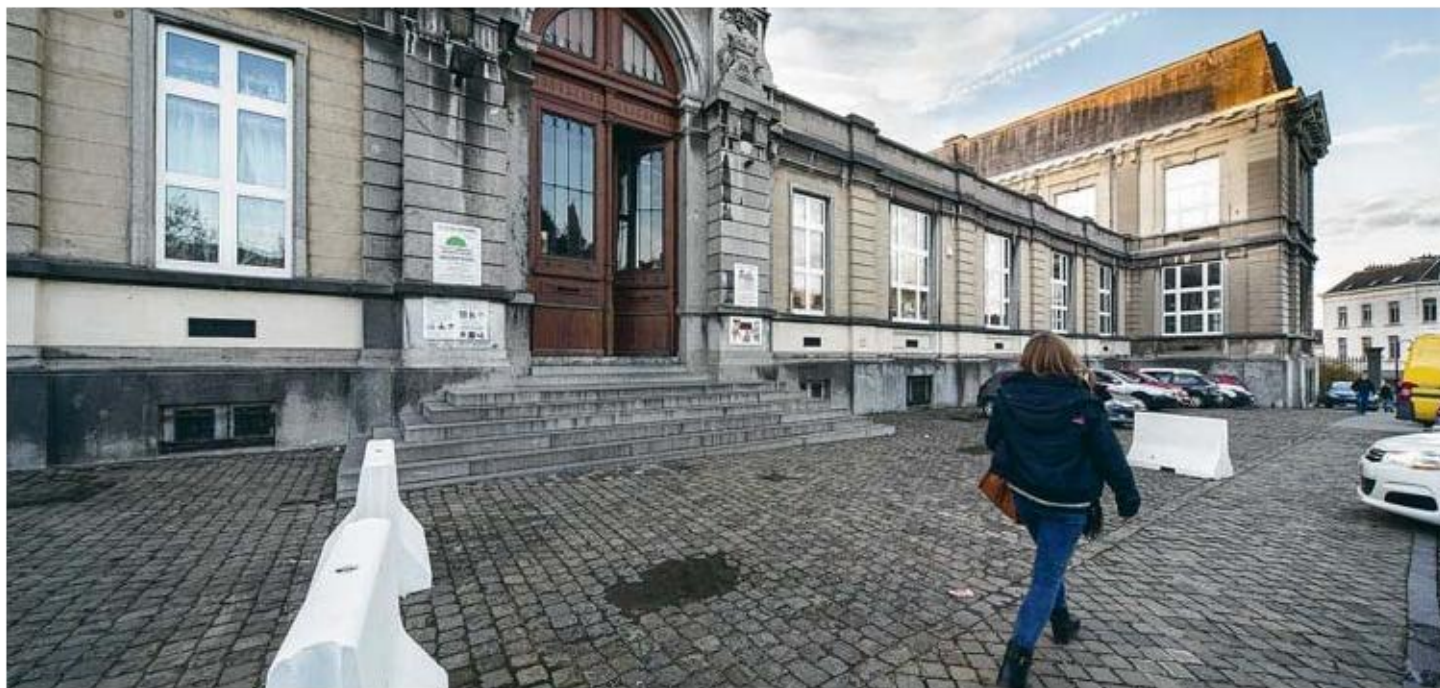
L'école communale de la rue de Séroule à Verviers est un exemple de bâtiment qui pourrait faire l'objet d'une rénovation énergétique dans le cadre de RenoWatt. © MICHEL TONNEAU
