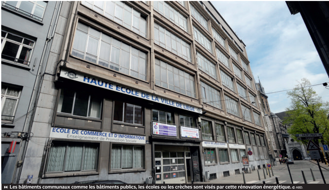
▶ Les bâtiments communaux comme les bâtiments publics, les écoles ou les crèches sont visés par cette rénovation énergétique. © ABD.
